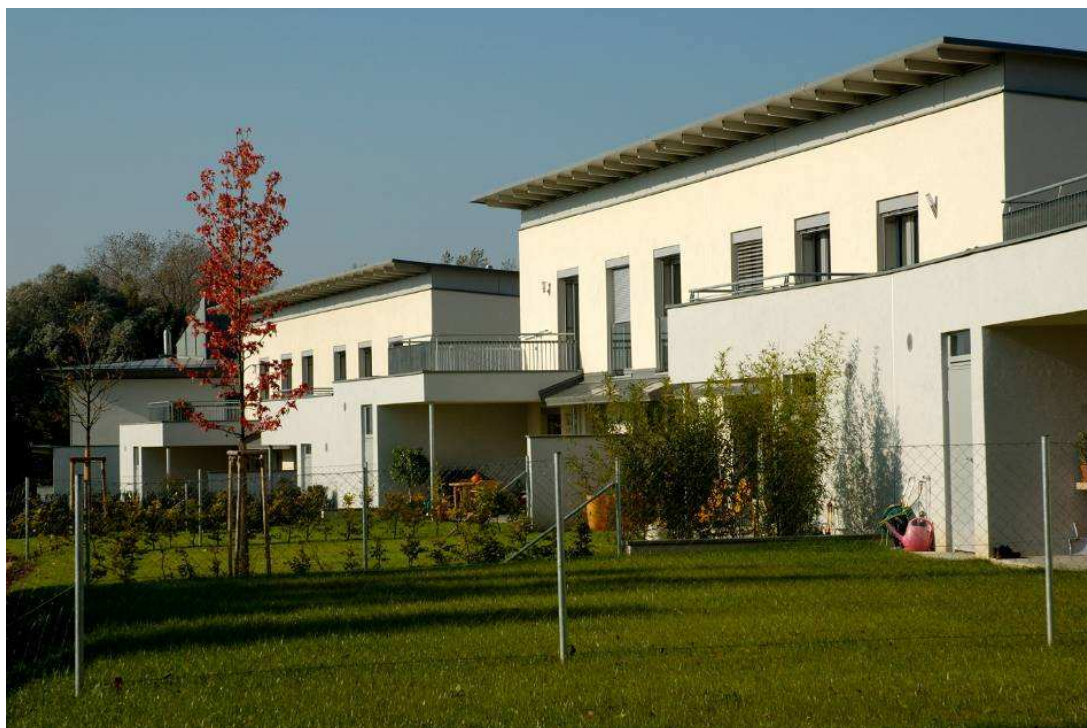
Fig. 3 Project Linz Hamoder
