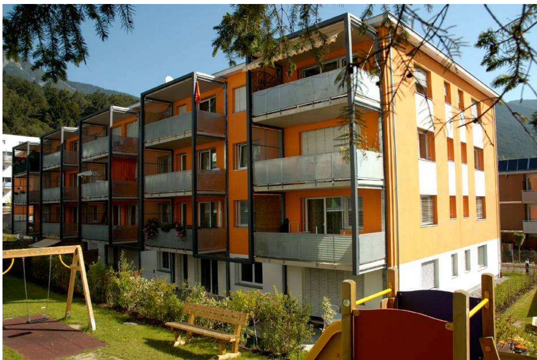
Fig. 5 Project Telfs Puite
